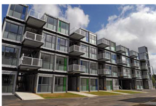
3 types de logements containers: les deux premiers sont hollandais; - Keetwonen (en haut) et NDSM Plein (milieu) Le dernier exemple est la résidente étudiante du havre (en bas).
