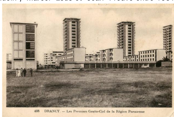
408 DRANCY. — Les Premiers Gratte-Ciel de la Région Parisienne Illustration d'avant guerre, de la cité de la Muette à Drancy
